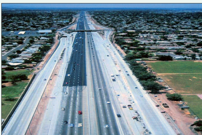
Figura 4 - Un esempio di riduzione del rumore sulla Interstate 17 a Phoenix (Arizona): a destra, nel primo tratto, si nota una barriera fonoassorbente che termina dove comincia il tratto di asfalto nero, quello in Asphalt Rubber. Qui l'Arizona Department of Transportation (ADOT) ha effettuato diverse misurazioni fonometriche a 10 m dalla strada, a 15 m in corrispondenza della barriera fonoassorbente, infine a 120 nella zona residenziale
