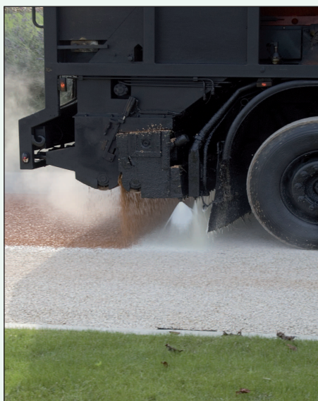
Figura 6 - La posa combinata per il trattamento superficiale a impregnazione, con spanditrice Flexible ed emulsione trasparente Emulcolorbit che, prima della rottura, è bianca. L'utilizzo di sistemi di posa simultanea di leganti e di graniglie ottimizza i dosaggi di leganti e di aggregati evitando dannosi sprechi e razionalizza le operazioni di posa riducendone i tempi e i disagi per la popolazione
