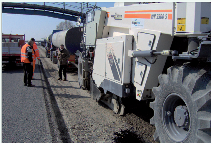
Figura 2 - La fresatura di pavimentazioni bitumate e di parte del misto di fondazione: il loro totale reimpiego mediante riciclaggio a freddo in situ con idonee emulsioni bituminose modificate evita costi ambientali ed energetici legati ad approvvigionamento e a movimentazioni di materiali; accresce inoltre le prestazioni meccaniche delle pavimentazioni
