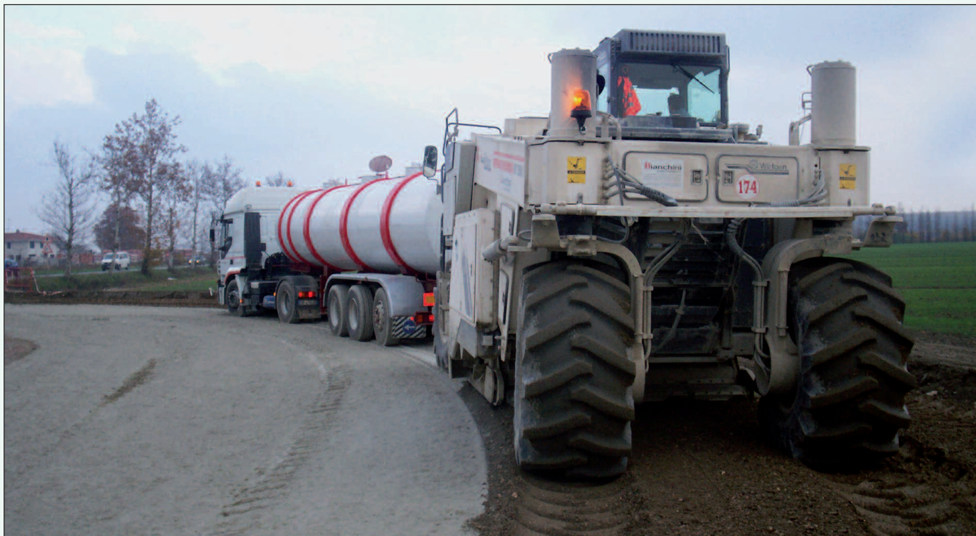
Figura 5 - Le tecniche oggi disponibili per la stabilizzazione dei terreni possono ridurre o addirittura evitare il pesante impatto di trasporti per la movimentazione di terreni e stabilizzato, offrendo fondi stabili e dalle ottime caratteristiche
