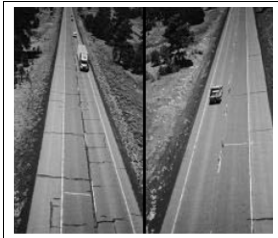
Confronto tra due tratti di pavimentazione della I-40, a sinistra in conglomerato tradizionale e a destra in AR, dopo 8 anni di servizio
