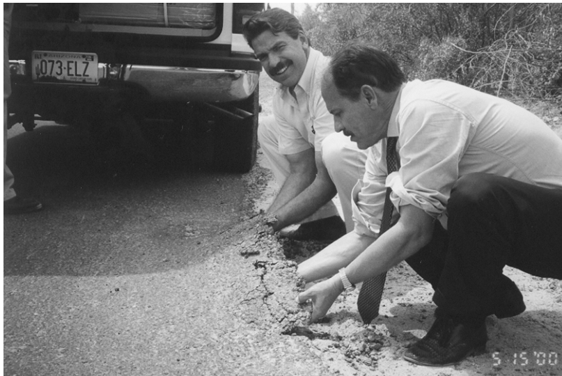
Figura 1: Immagine che mostra l'elevata elasticità e resistenza di un trattamento superficiale con AR applicato ad una strada bianca nel deserto dell'Arizona
