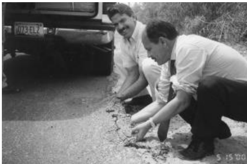
Immagine che mostra l'elevata elasticità e resistenza di un trattamento superficiale con AR applicato ad una strada bianca nel deserto dell'Arizona
