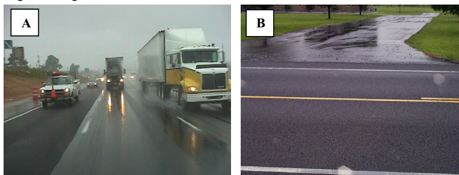
Figura 3 – Soluzione Asphalt Rubber nella IH35 San Antonio (Texas). Corsia drenante e corsia tradizionale (A); particolare della superficie finita (B).
