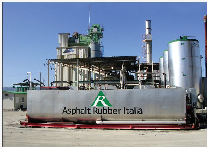
Figura 3 - L'impianto Asphalt Rubber Italia per la produzione del Bitume Modificato Rubbit, in esso il polverino di gomma reagisce ad alte temperature con il bitume (metodo "Wet")
