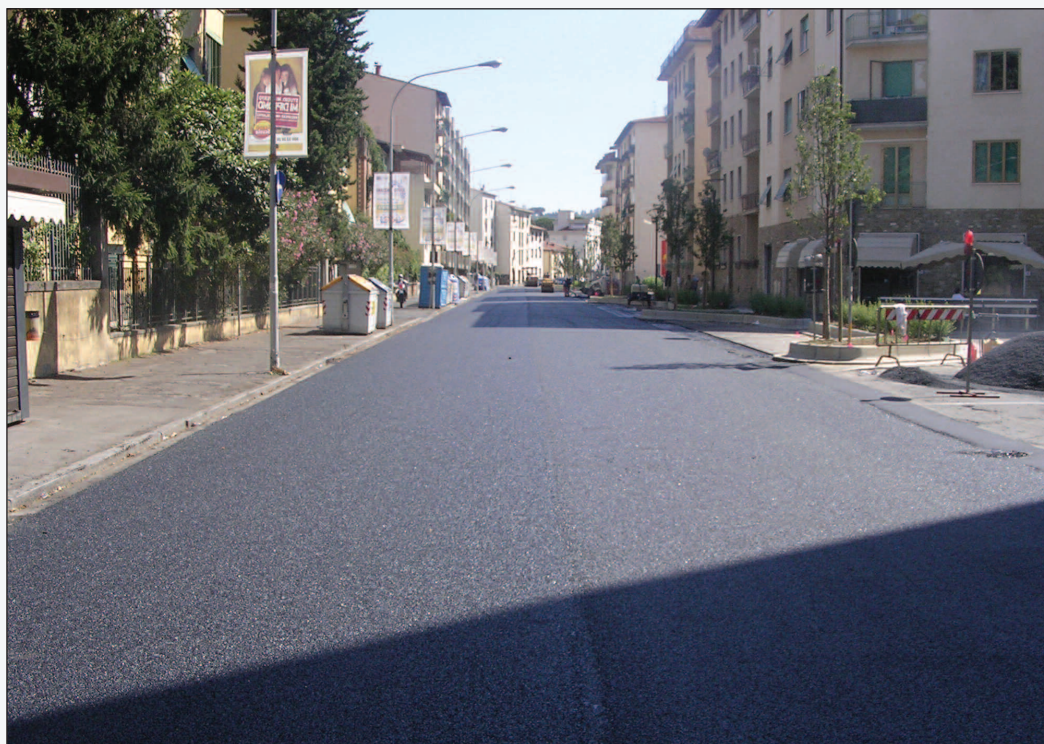
Figura 6 - La pavimentazione di Via Erbosa nella città di Firenze realizzata in conglomerato bituminoso Asphalt Rubber sia di tipo open graded sia gap graded
