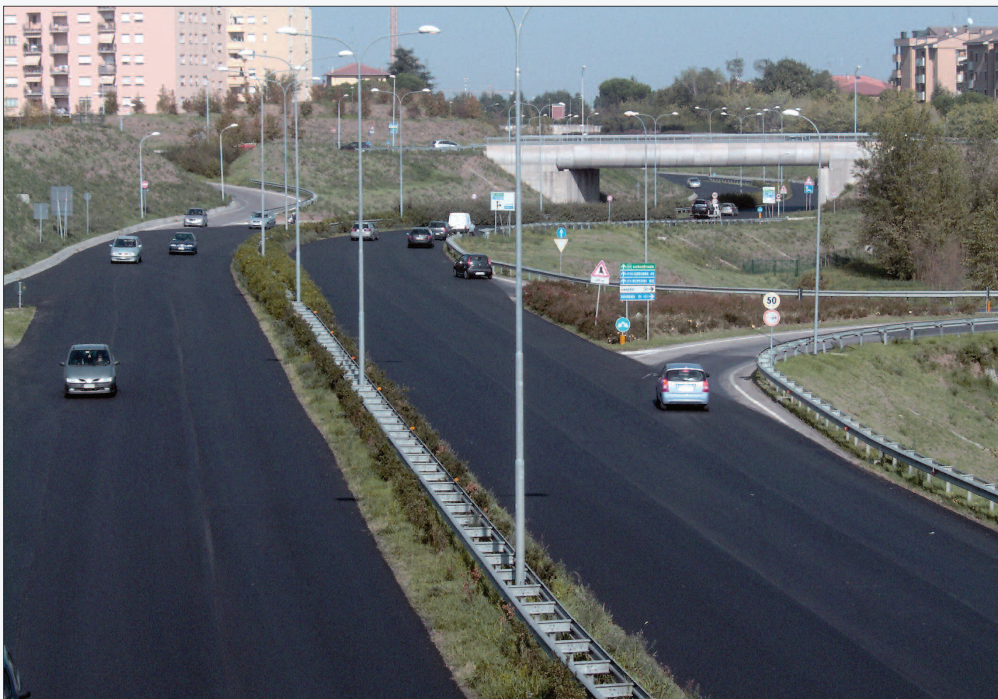
Figura 5 - La pavimentazione dell'asse attrezzato nella città di Imola, realizzato con conglomerato bituminoso Asphalt Rubber gap graded
