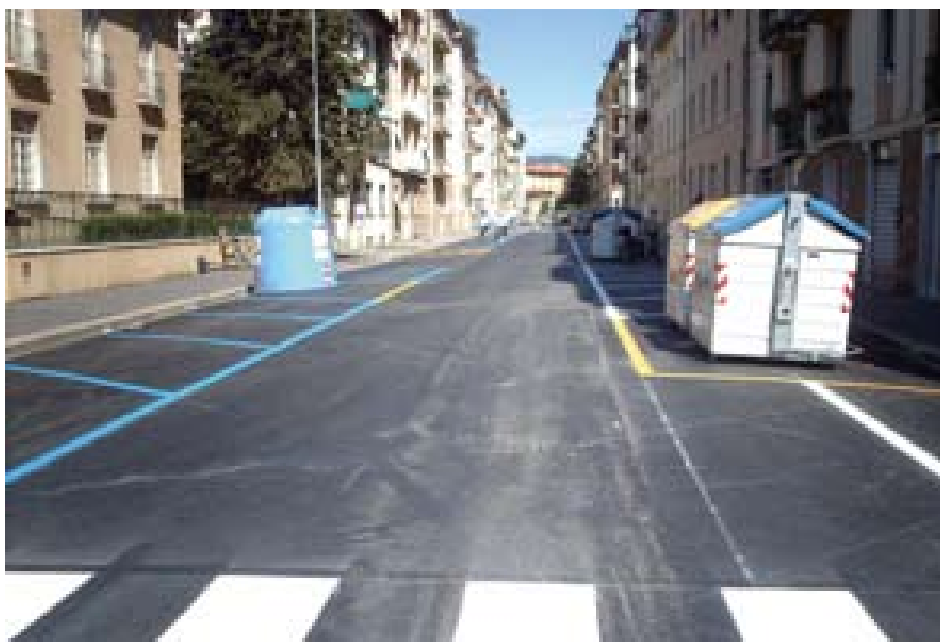
Via del Bandino, dove sono appena conclusi i lavori
